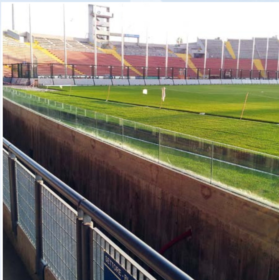
Stadio Friuli, Udine (Italy) - Sistema DEFENDER, barriera di sicurezza realizzata ad incasso. (foto in corso d'opera, i carter di finitura saranno montati a lavoro finito)
