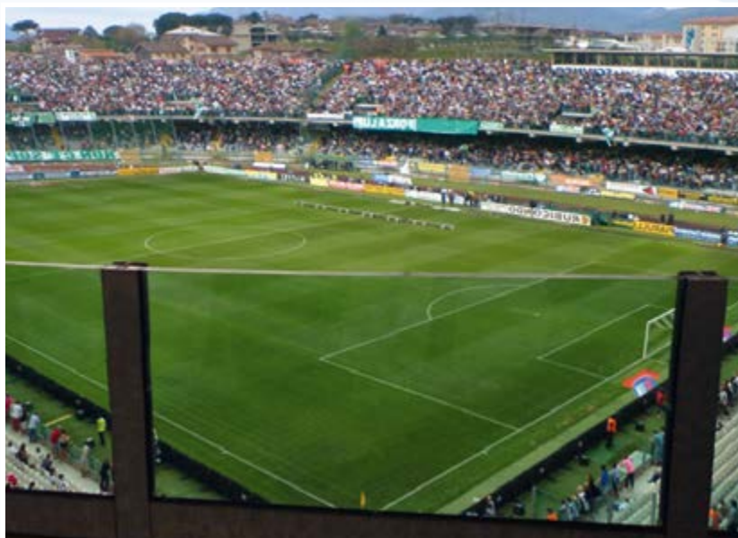
Esempio di parapetto con montanti metallici. Visuale decisamente ridotta.
