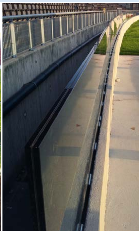
Stadio Friuli, Udine (Italy) - Sistema DEFENDER, barriera di sicurezza realizzata ad incasso. (foto in corso d'opera, i carter di finitura saranno montati a lavoro finito)
