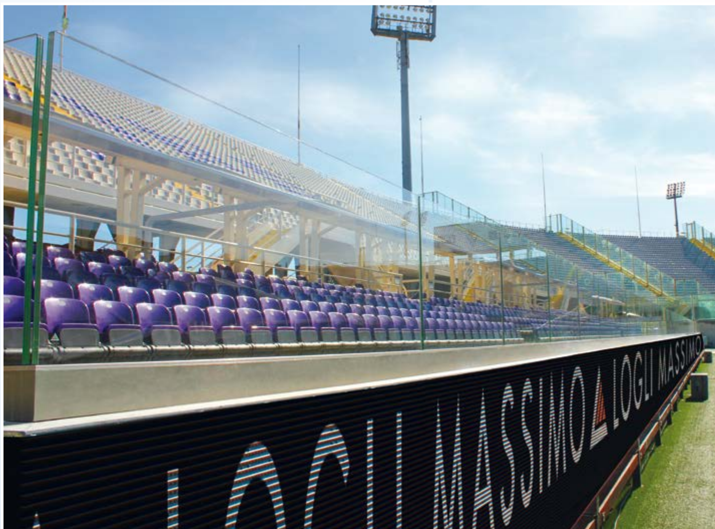
Stadio Artemio Franchi, Firenze (Italy), tribuna autorità – Sistema DEFENDER, visuale non disturbata da elementi metallici.
